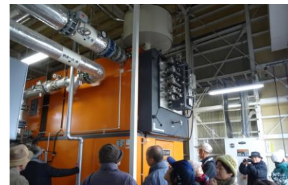
山形最上町バイオマスボイラー
